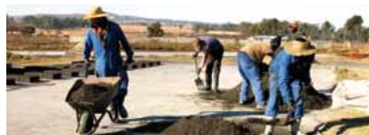
AFRIQUE DU SUD, JOHANNESBURG — (Quartier Orange Farm). Groupe Emmaüs Cordis, fabrication de brique par les compagnons. SOUTH AFRICA, JOHANNESBURG — (Orange Farm district). Emmaus Cordis, companions making bricks. SUDÁFRICA, JOHANNESBURGO — (Barrio de Orange Farm). Grupo Emaüs Cordis, compañeros fabricando ladrillos.
